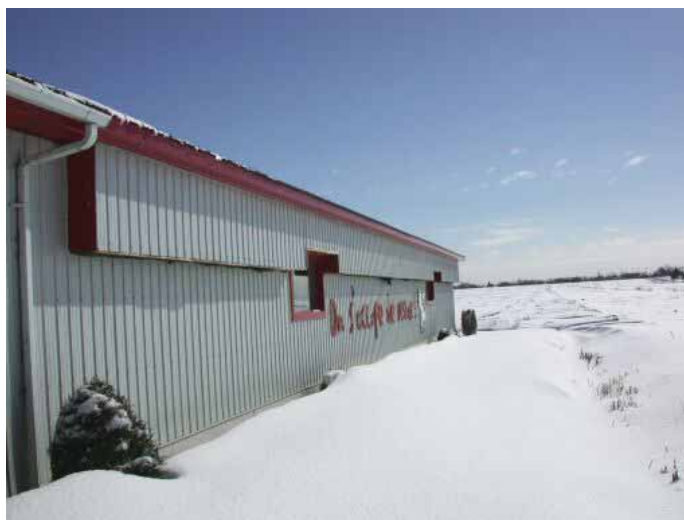
Figure 4. Vue de l'extérieur du site no. 2.
