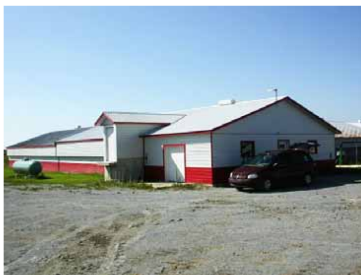
Figure 6. Vue de l'extérieur du site no. 3.
